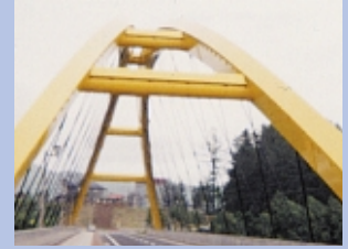
橋梁着雪防止板
