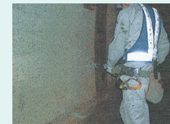
①アンカー打設
