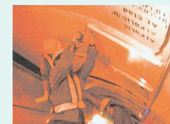
⑤アルポリック®表面板取付
