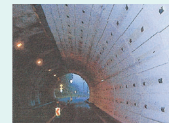
③断熱材取付 (寒冷地以外では省略可)
